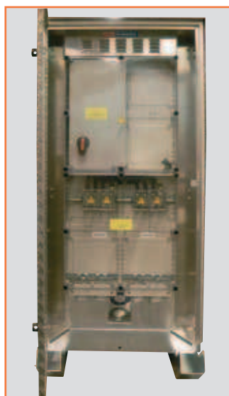
Abwärtstrafo: Vorder- und Rückseite Eingang 1000V / Abgang 400V
