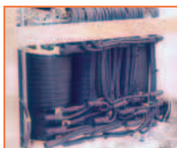
Hochwertiger Trenntransformator mit äußerst niedrigen Leerlaufverluste unter 0,5%
