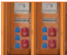
gut zugänglicher Steckdosenbereich
