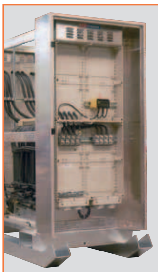
Aufwärtstrafo: Vorder- und Rückseite Eingang 400V / Abgang 1000V
